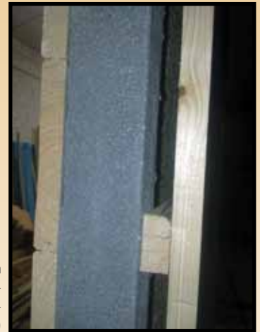
Sándwich estructural 120mm (madera + estructura metálica + aislante + aislante de vapor + rastrel + (cámara de aire) + madera)
