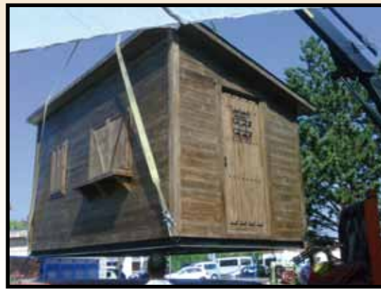
Sándwich estructural 120mm (madera + estructura metálica + aislante + aislante de vapor + rastrel + (cámara de aire) + madera)
